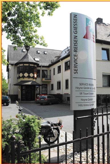
Rödgener Strasse 12, SR-Zentrale
