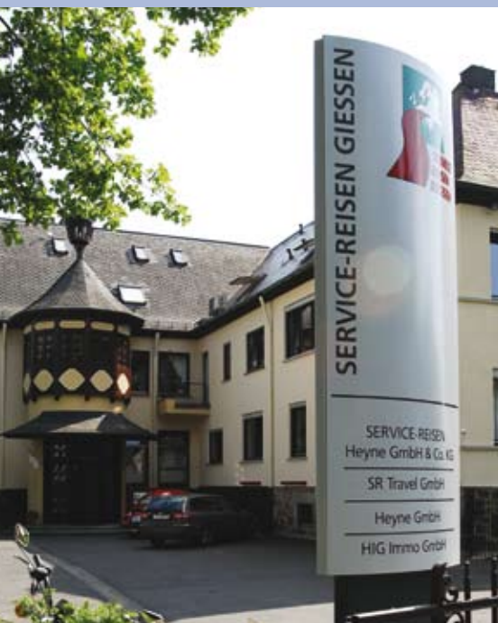
Rödgener Strasse 12, SR-Zentrale
